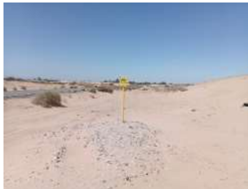
Figura 32: Señalización de gasoducto existente.
