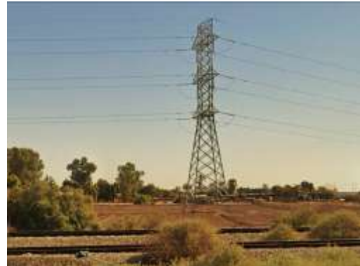
Figura 69 : Línea de alta tensión en Ejido Guanajuato cruce con el gasoducto de proyecto.
