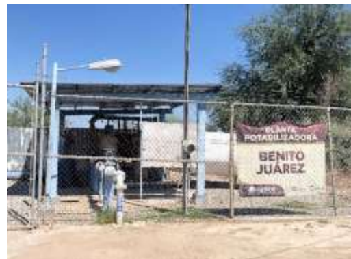
Figura 58 : Planta potabilizadora de agua "Benito Juárez" en Ejido Benito Juárez.
