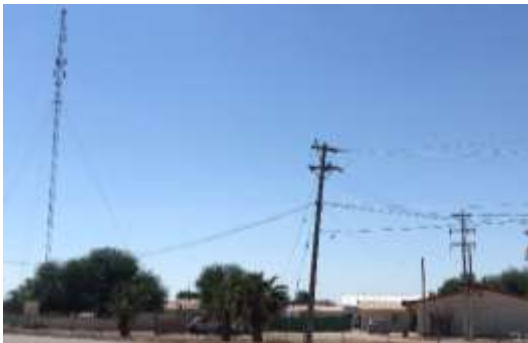
Figura 77 : Antena en Clínica de Rehabilitación Física.
