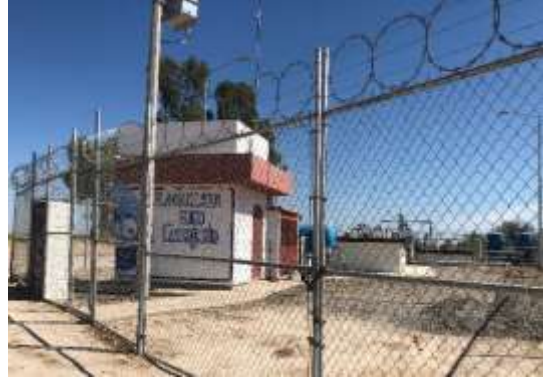
Figura 54 : Planta potabilizadora de agua en Ejido Aguascalientes.
