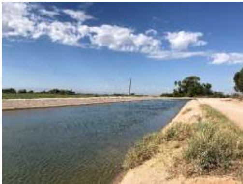
Figura 66 : Tramo del Canal Independencia por donde cruzará el gasoducto de proyecto.
