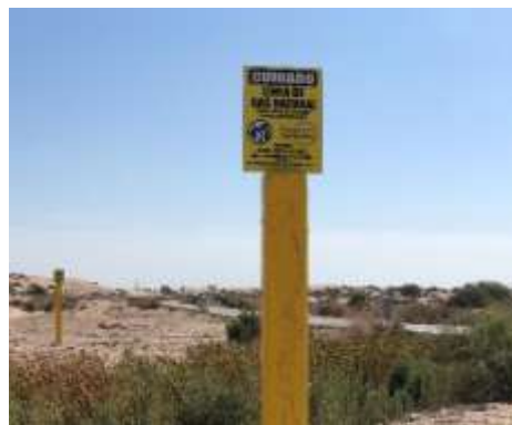
Figura 71 : Gasoducto "Rosarito" existente junto a la Carr. Federal 8
