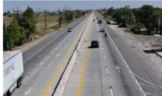
Figura 45: Cruce con carr. Mexicali - San Luis Río Colorado, Son.
