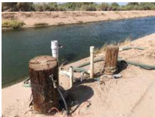
Figura 60 : Tomas de agua en Canal Independencia de rancherías del Ejido Tula.
